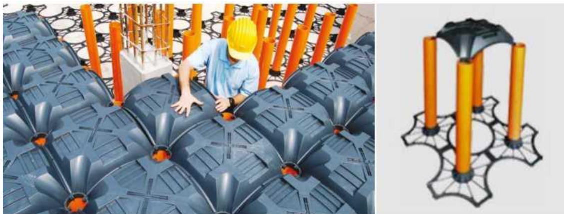
Рис. 6.5 Опалубка Novyu Elevator
