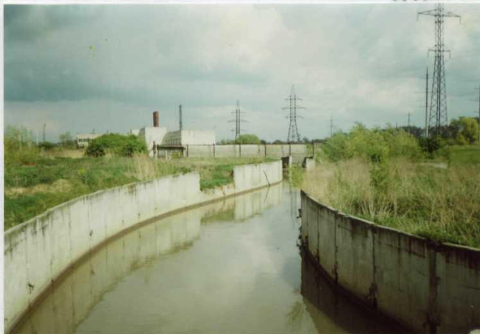
Ріка Полтва перед очисними спорудами
