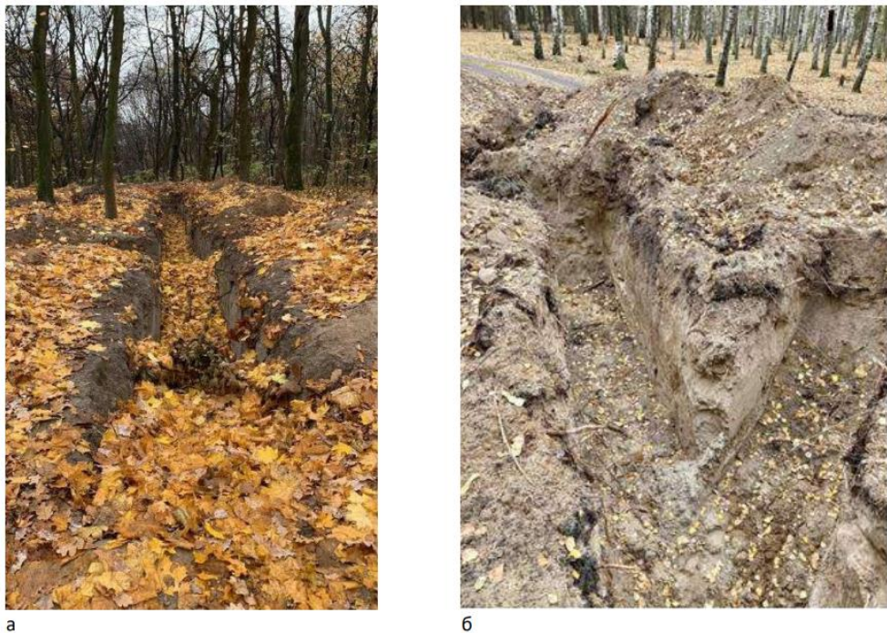
Рисунок 3.9 – Приповерхневі фортифікаційні споруди – траншеї: а) поблизу м. Київ; б) поблизу м. Тростянець Сумської області
