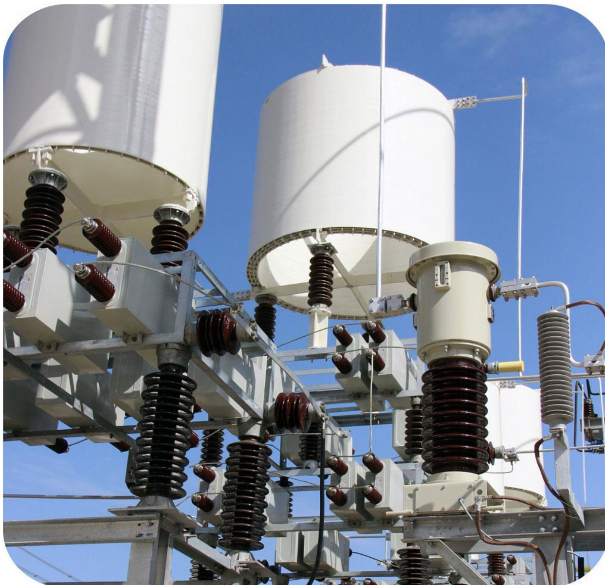
Рисунок 1.3 – Статичні тиристорні компенсатори (СТК / SVC)
