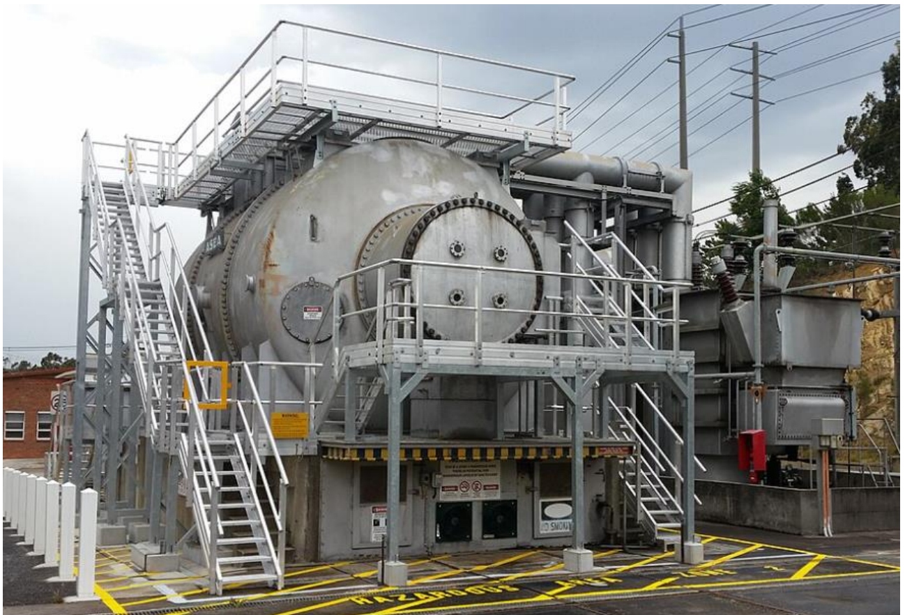
Рисунок 1.4 – Синхронний компенсатор
