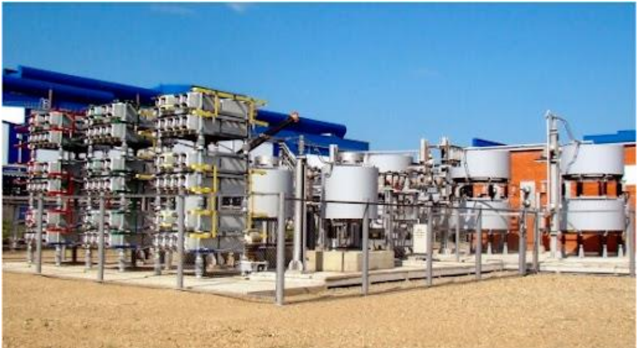
Рисунок 1.5 – Статичні тиристорні компенсатори (СТК / SVC)
