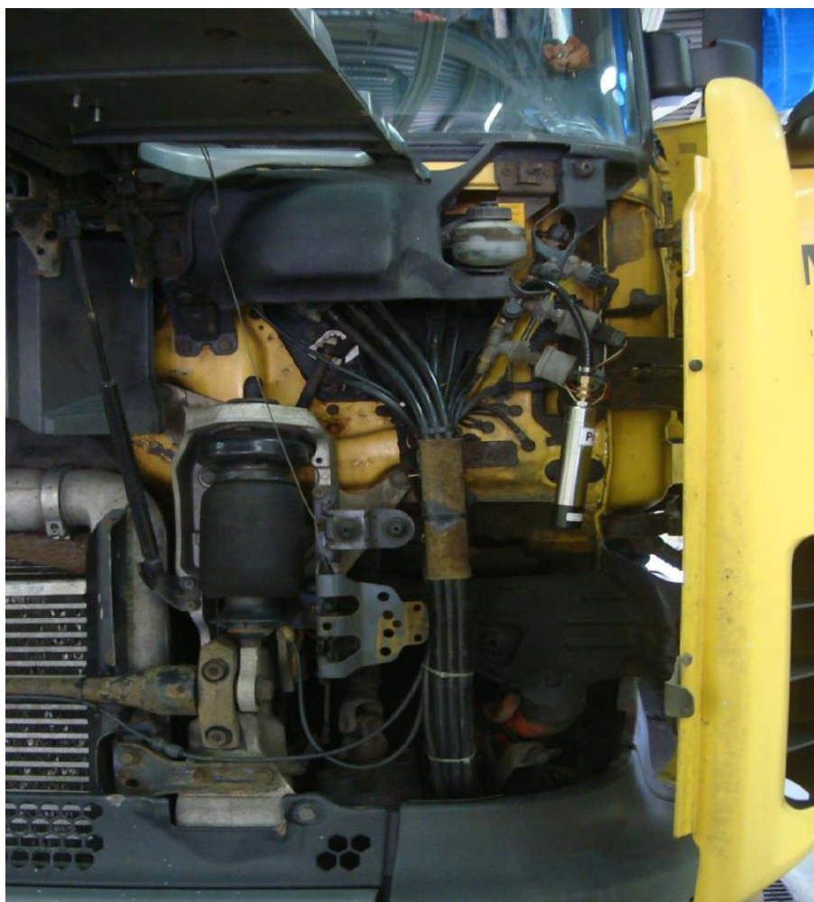
Рисунок 3.9. Установка сенсора тиску P_m на вихід з компресора тягача
