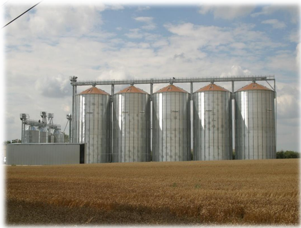
Рисунок 2.7 - Загальний вигляд металевих зерносховищ
