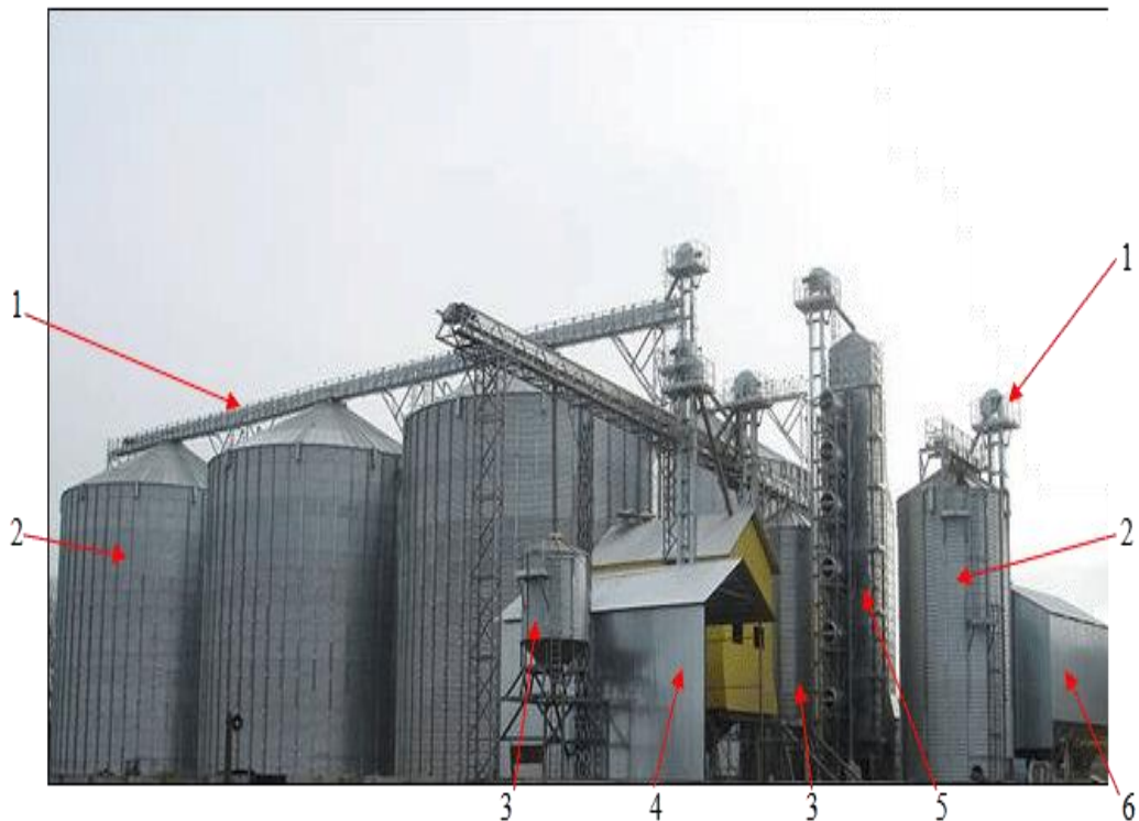
Рисунок 2.3 - Загальний вигляд силосного типу зерносховища
