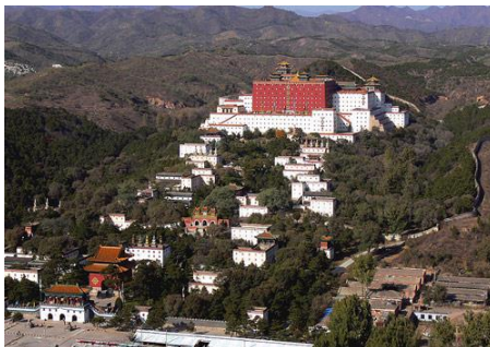
Рис. 17. Загальний вигляд храмового комплексу
