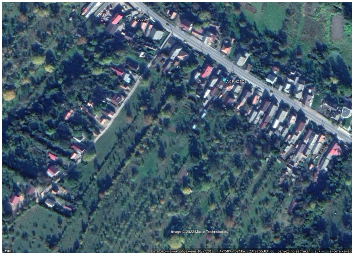
Рис. Фрагмент забудови та присадибних територій с. Ремета (Румунія). Сформовано автором з використанням сервісу Google Earth Pro .
