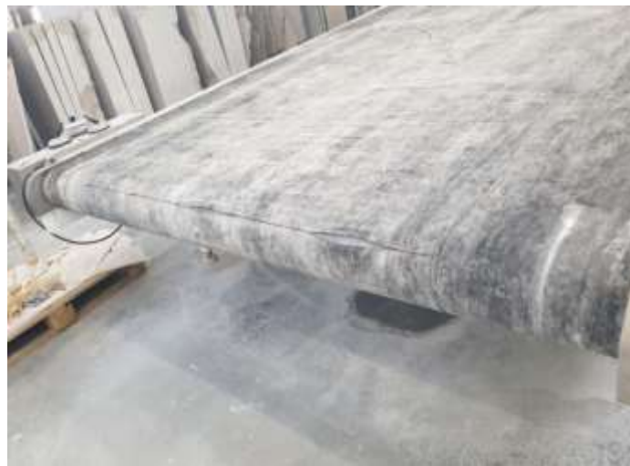
Рис. 1.14. Утворення тріщин і порив конвеєрної стрічки
