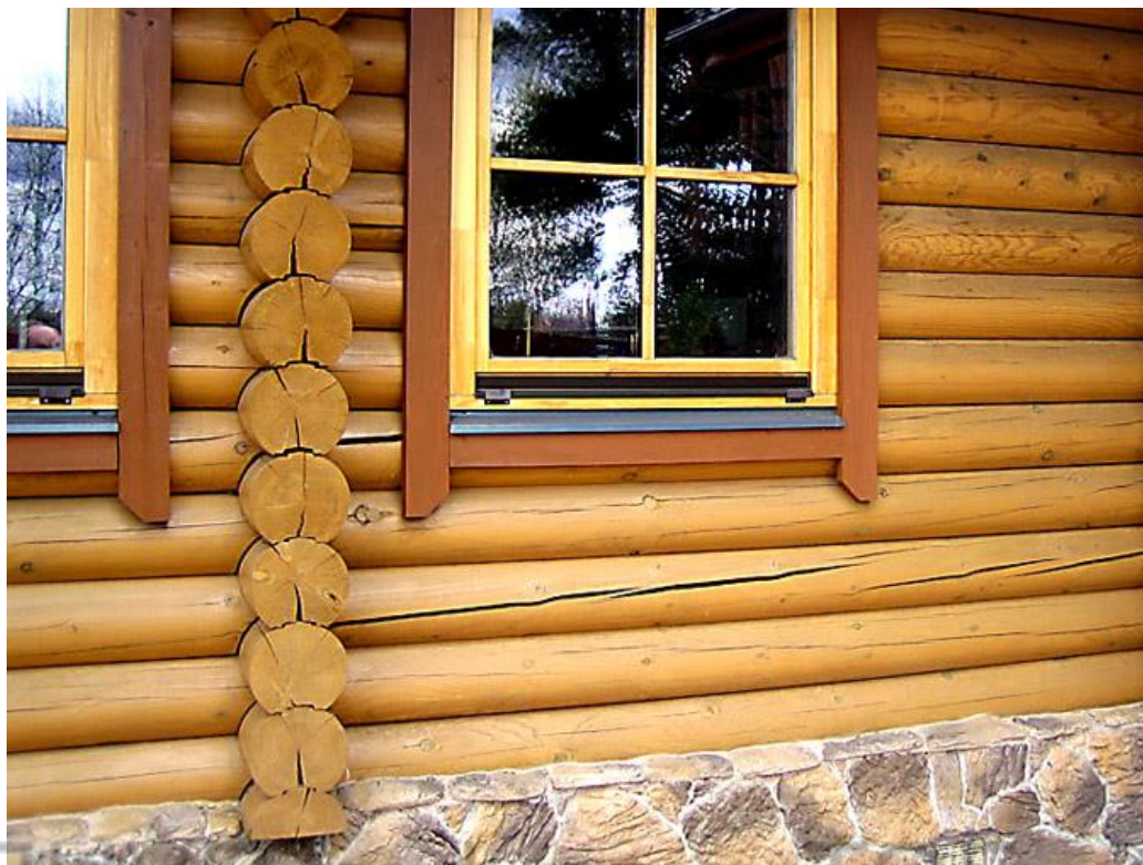
Рис. 6.9 Радіальне й кільцеве розтріскування колод
