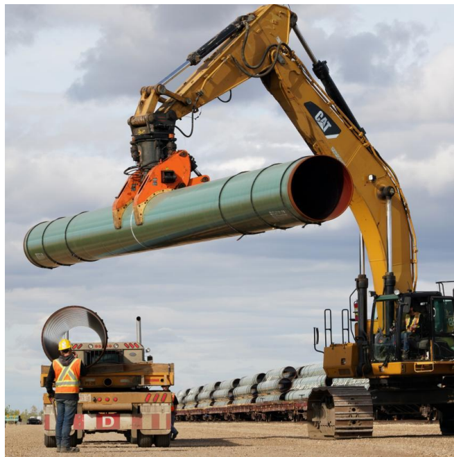
Рисунок 1.4 – Застосування маніпуляторних установок на будівництві
