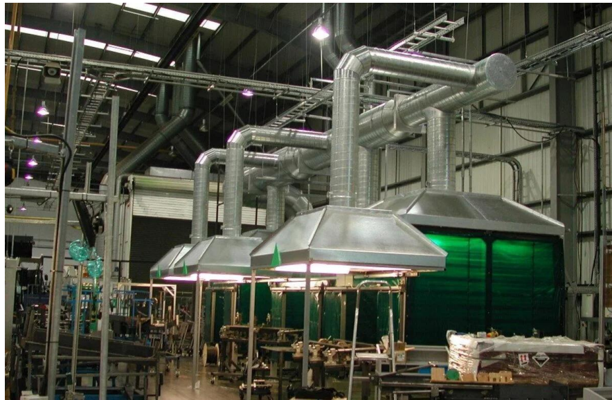
Рисунок 3.2 – Система аспірації та вентиляції
