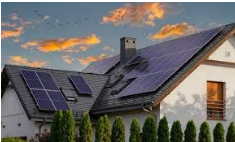
Рисунок 1.1 - Автономна сонячна електростанція
