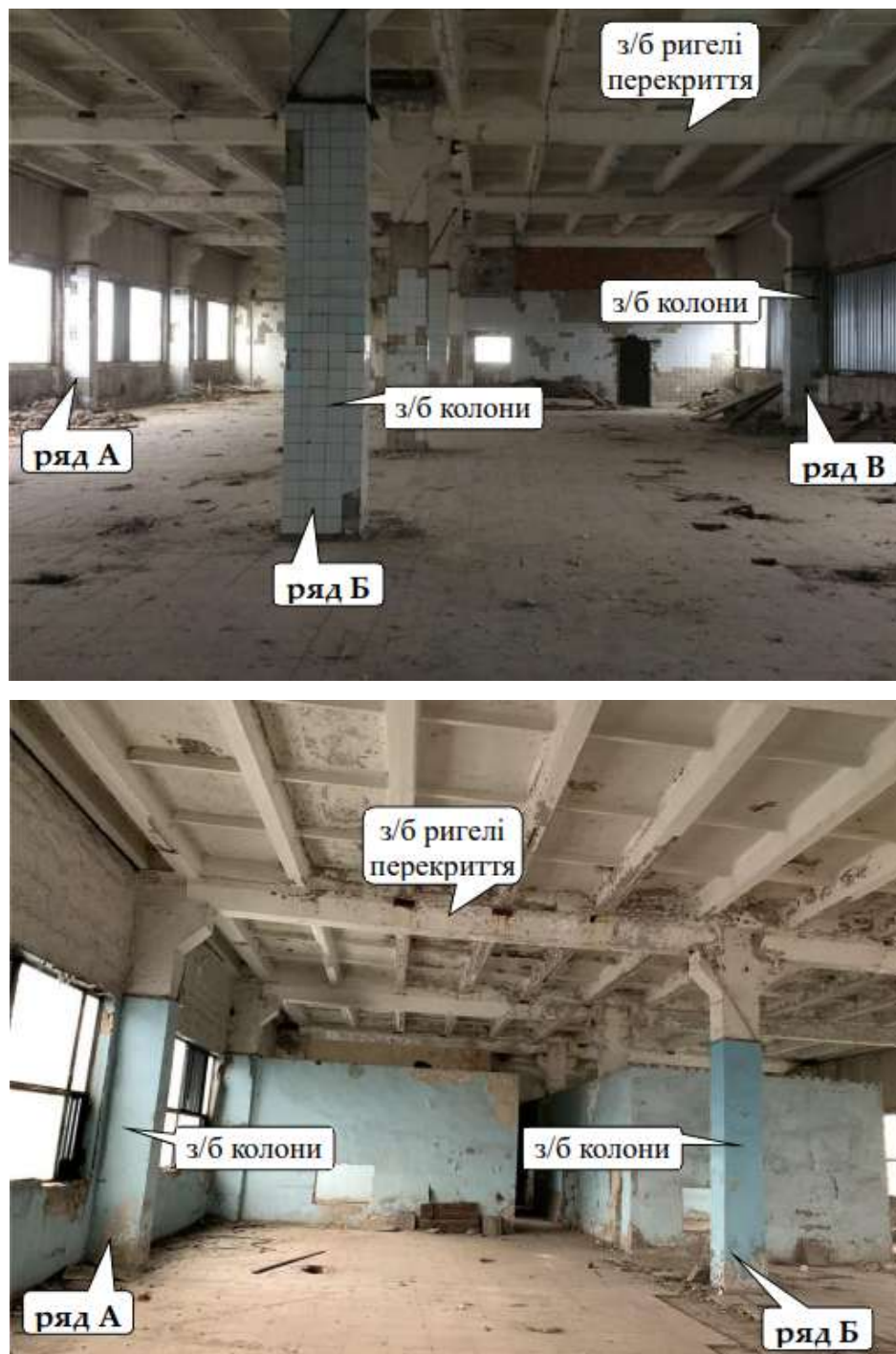
Рис. 2.3. Фактичний стан приміщень промислової будівлі до її реконструкції зсередини. Виділення основних її несучих конструкцій
