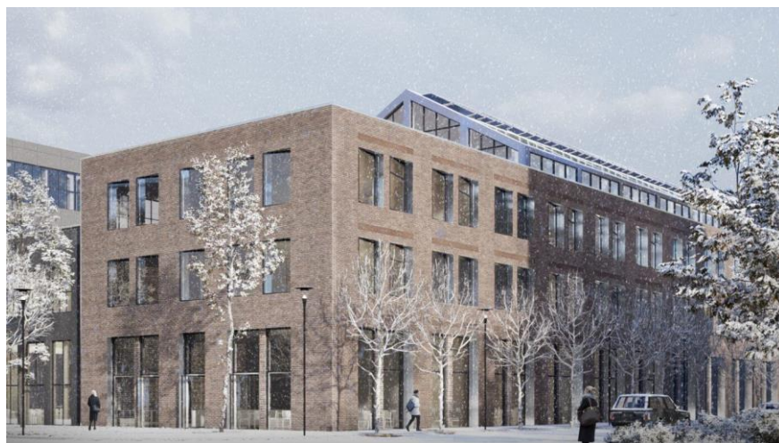
Рис. 5. "Промприлад. Renovation" в Івано-Франківську
