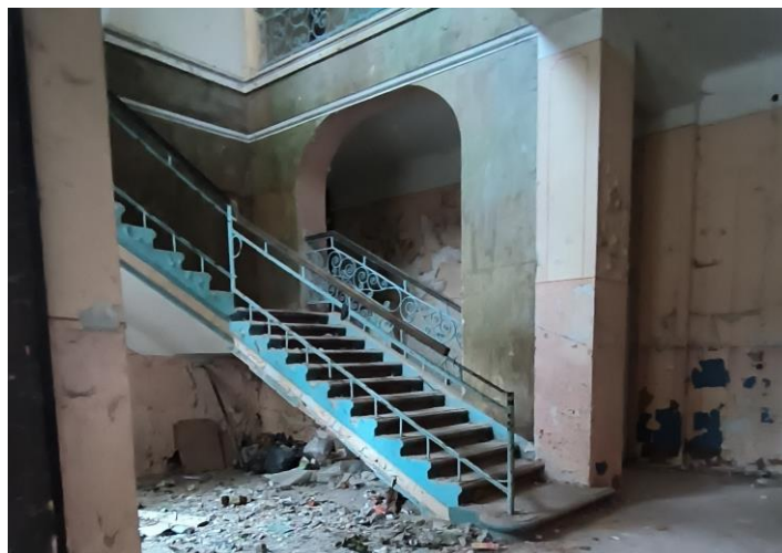
Рис.34 Внутрішні тримаршеві сходи
