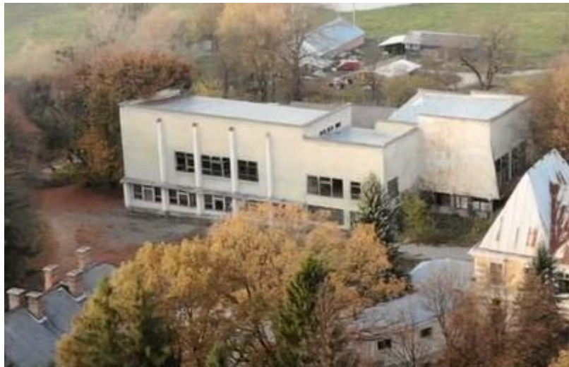
Рис.29 Двоповерхова будівля їдальні санаторію
