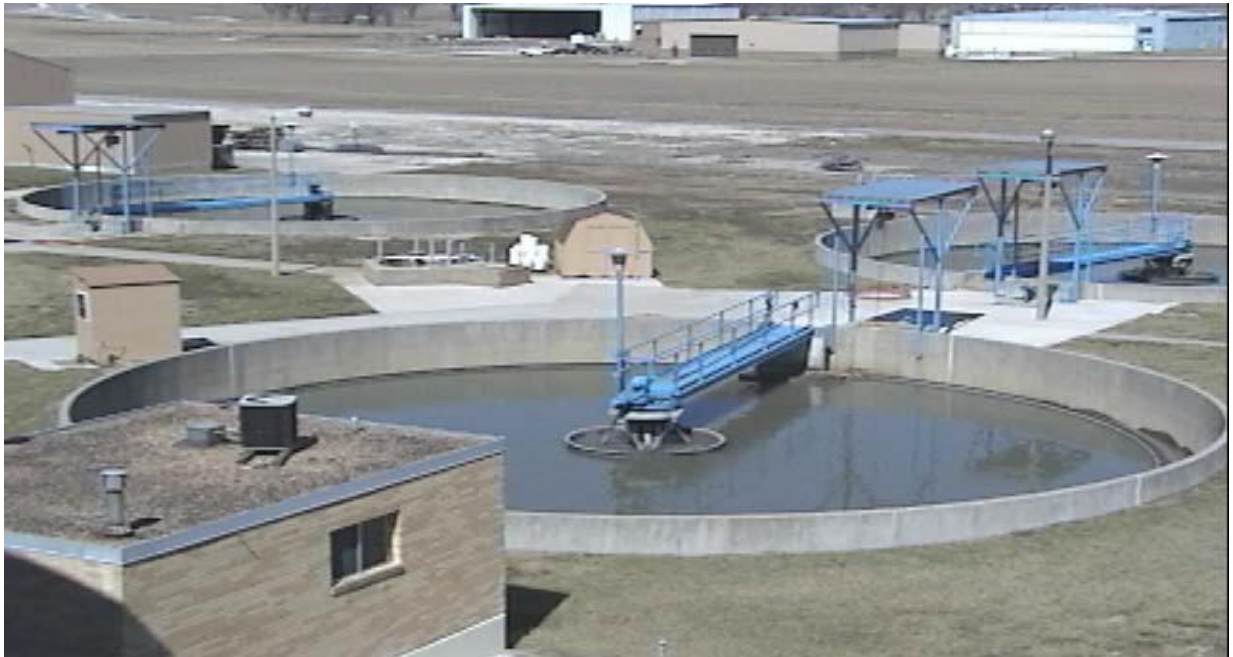
Рисунок 2.6 – Загальний вигляд трьох із чотирьох ємкостей первинної очистки в м. Джефферсон-сіті
