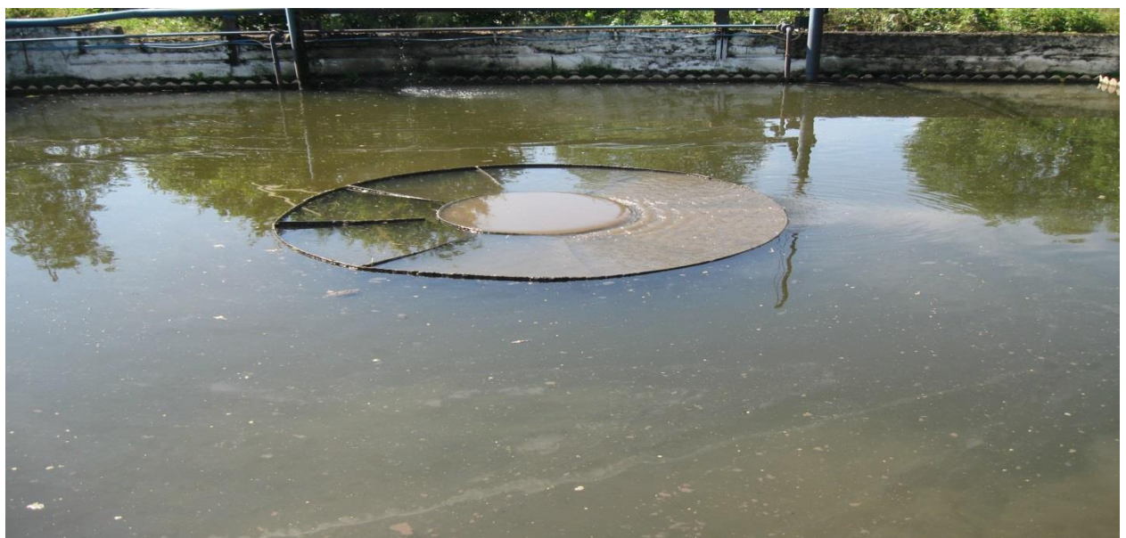
Рисунок 2.7 – Загальний вигляд вторинного відстійника блоку біологічного очищення (Долинське ВУВКГ)
