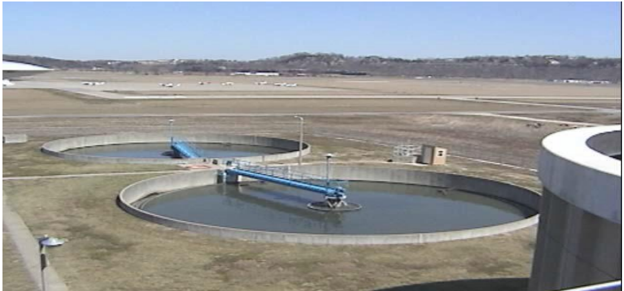
Рисунок 2.8 – Загальний вигляд двох очисних ємкостей другого ступеня очистки в м. Джефферсон-сіті
