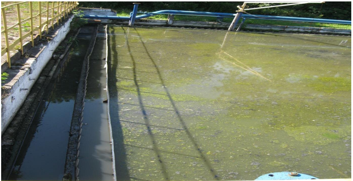
Рисунок 2.5 – Загальний вигляд первинного відстійника (Долинське ВУВКГ)
