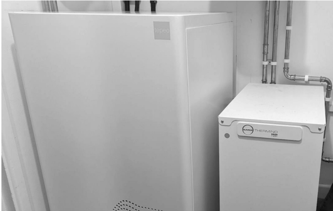
Рис. 2.6 Тепловий акумулятор від фірми Sunamp-Терео на базі натрій-ацетату тригідрату.
