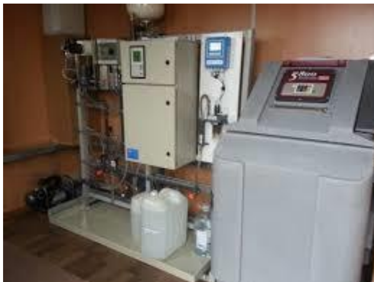
Світлина 1.1 Станція автоматичного моніторингу стічних вод та поверхневих водойм
