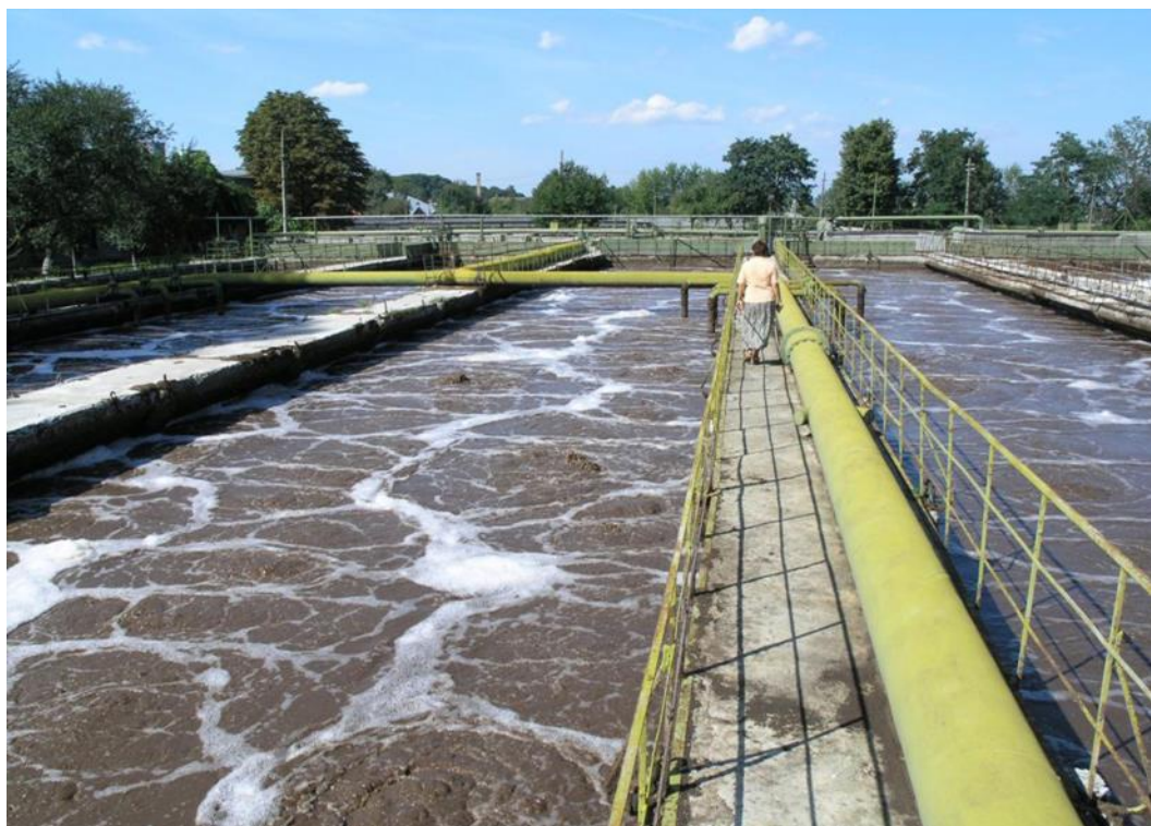
Рис. 3.2 – Аеротенки повного біологічного очищення стічних вод.
