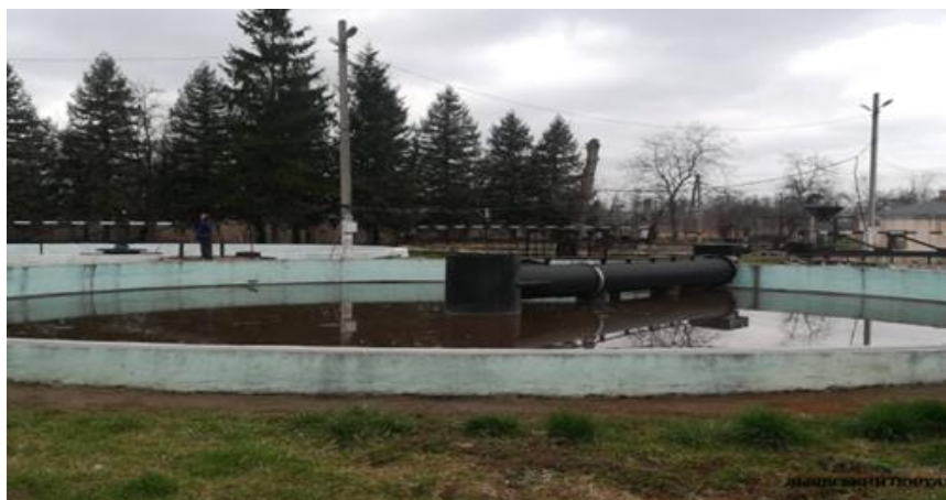
Рисунок 3.3 – Вторинний радіальний відстійник на очисних спорудах.
