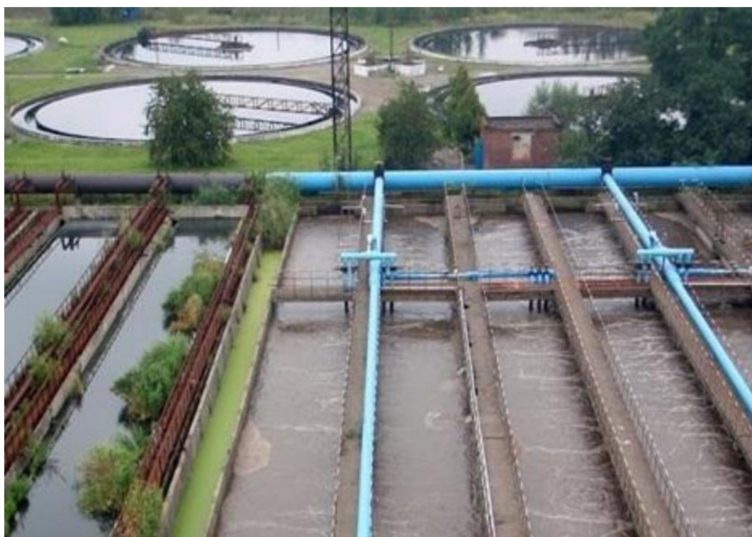
Рисунок 3.1 – Каналізаційні очисні споруди м. Львова
