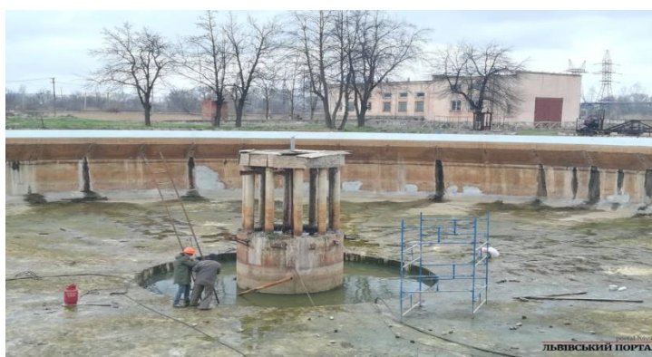
Рисунок 3.4 – Проведення ремонтно-оглядових робіт у вторинному радіальному відстійнику на території очисних споруд.
