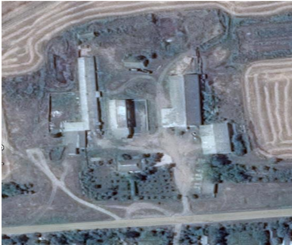
Рисунок 1.2 - Знімок зі супутника підприємства ФГ «Мрія агро лан» з будівлями.
