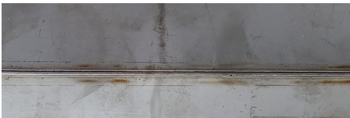
Рисунок 3.10 – Випадок непроварювання шва
