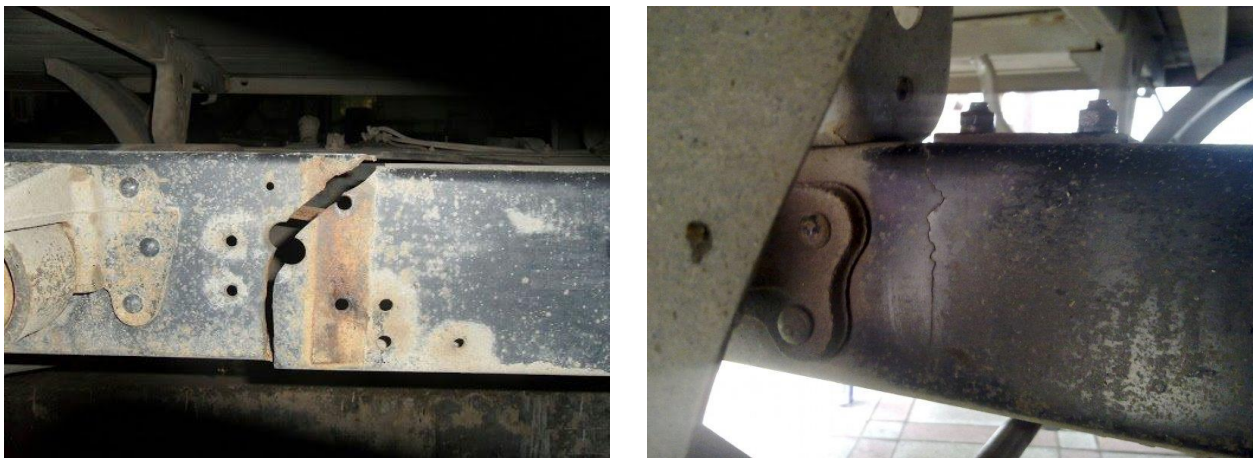
Рисунок 1.7 – Тріщини рами біля місць кріплення кронштейнів.
