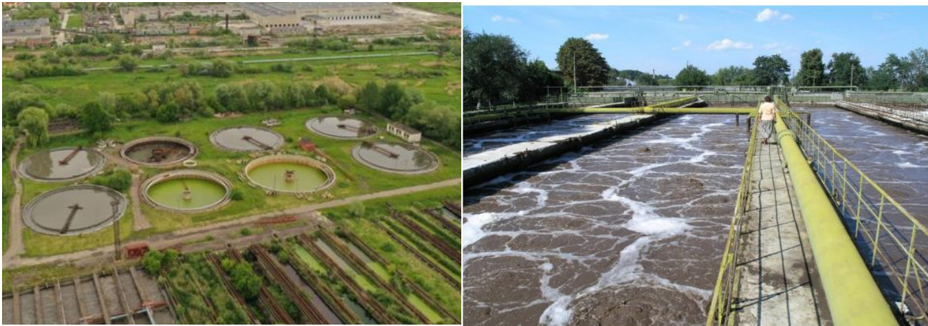
Рисунок 3.1 – Очисні споруди ЛМКП «Львівводоканал» [15]
