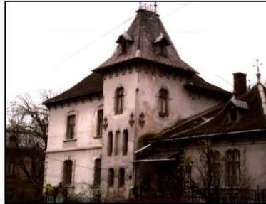
Рис. 1.12. Загальний вигляд будинку на вул. Вербицького, 4
