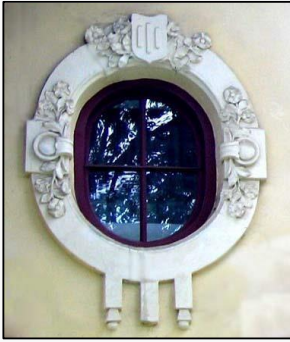
Рис. 3.70. Обрамлення вікна на будинку на вул. Коновальця, 80
