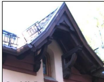
Рис. 3.52. Дерев'яна конструкція піддашся будинку на вул. Коновальця, 16 (1904 р.)
