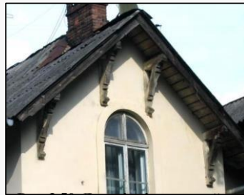
Рис. 3.50. Дерев'яні кронштейни будинку на вул. Рудницького, 9 (арх. М. Ковальчук, 1911 р.)
