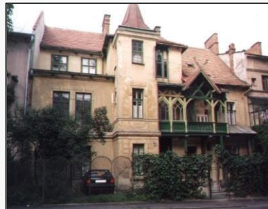
Будинок на вул. Котляревського, 29, 1891 р.
