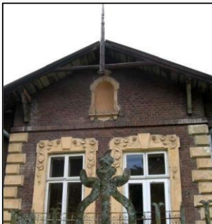
Рис. 3.47. Фрагмент фасаду будинку на вул. Антоновича, 54
