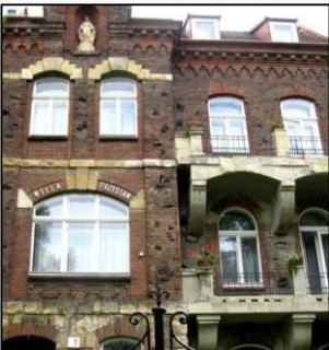
Рис. 3.46. Фрагмент фасаду будинку на вул. Парковій, 7
