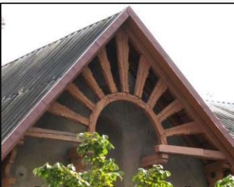
Рис. 3.51. “Мотив сонця” у конструкції піддашся на будинку на вул. Антоновича, 75
