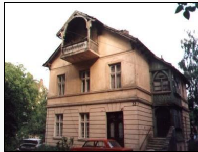
Будинок на вул. Котляревського, 33, 1891 р.
