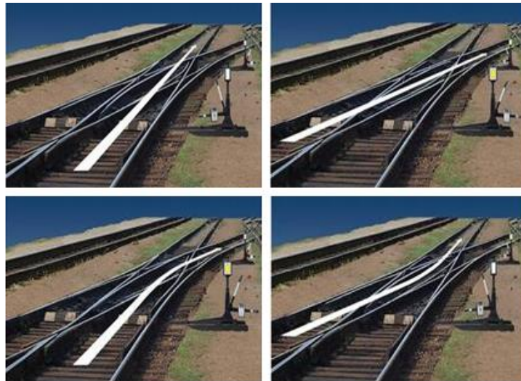
Рисунок 1.6 - Напрямки руху на перехресному стрілочному переводі
