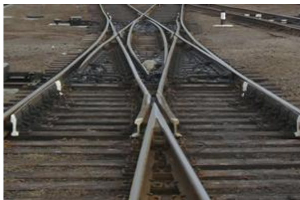
Рисунок 1.5 - Перехресний стрілочний перевід
