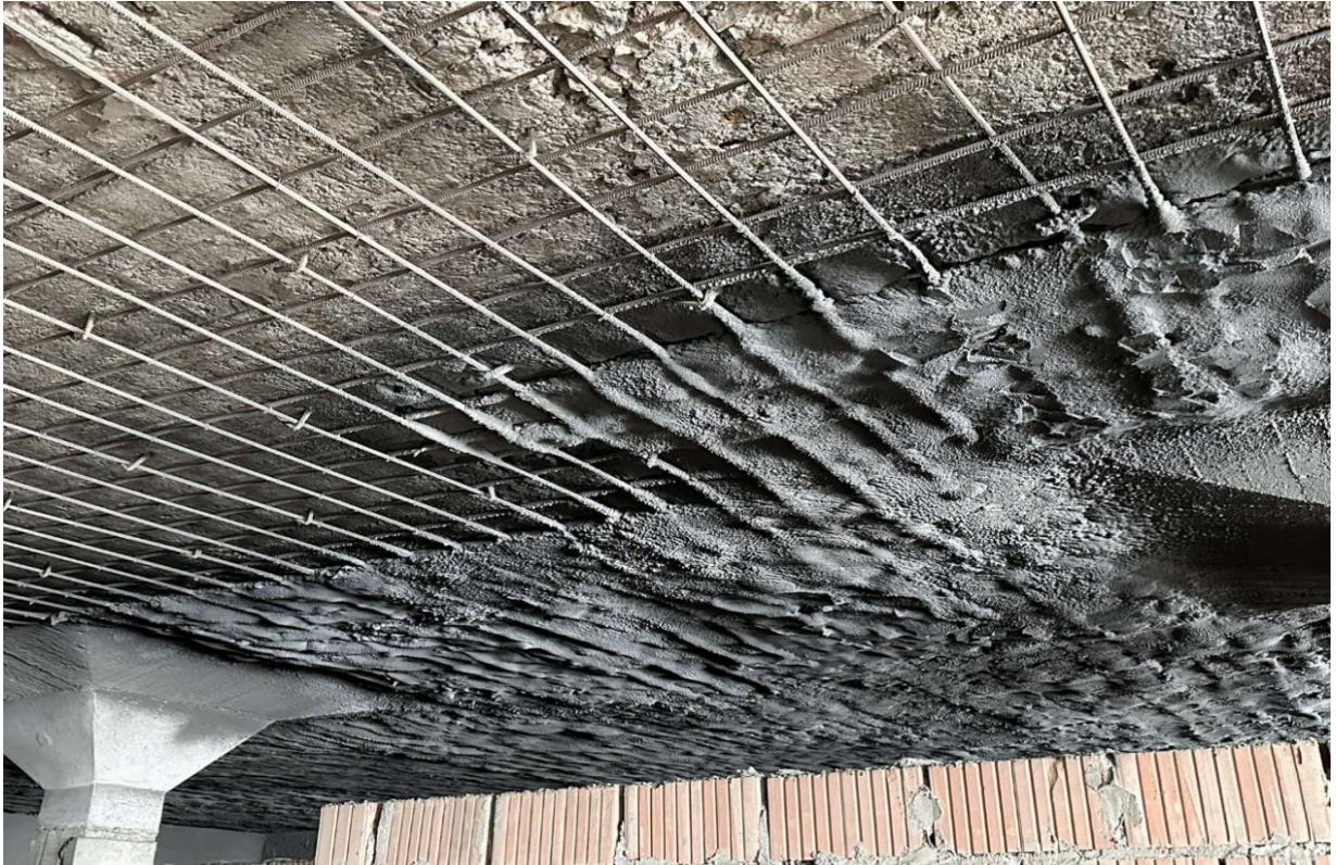
Рис. 3. Загальний вигляд нанесення шару торкретбетону
