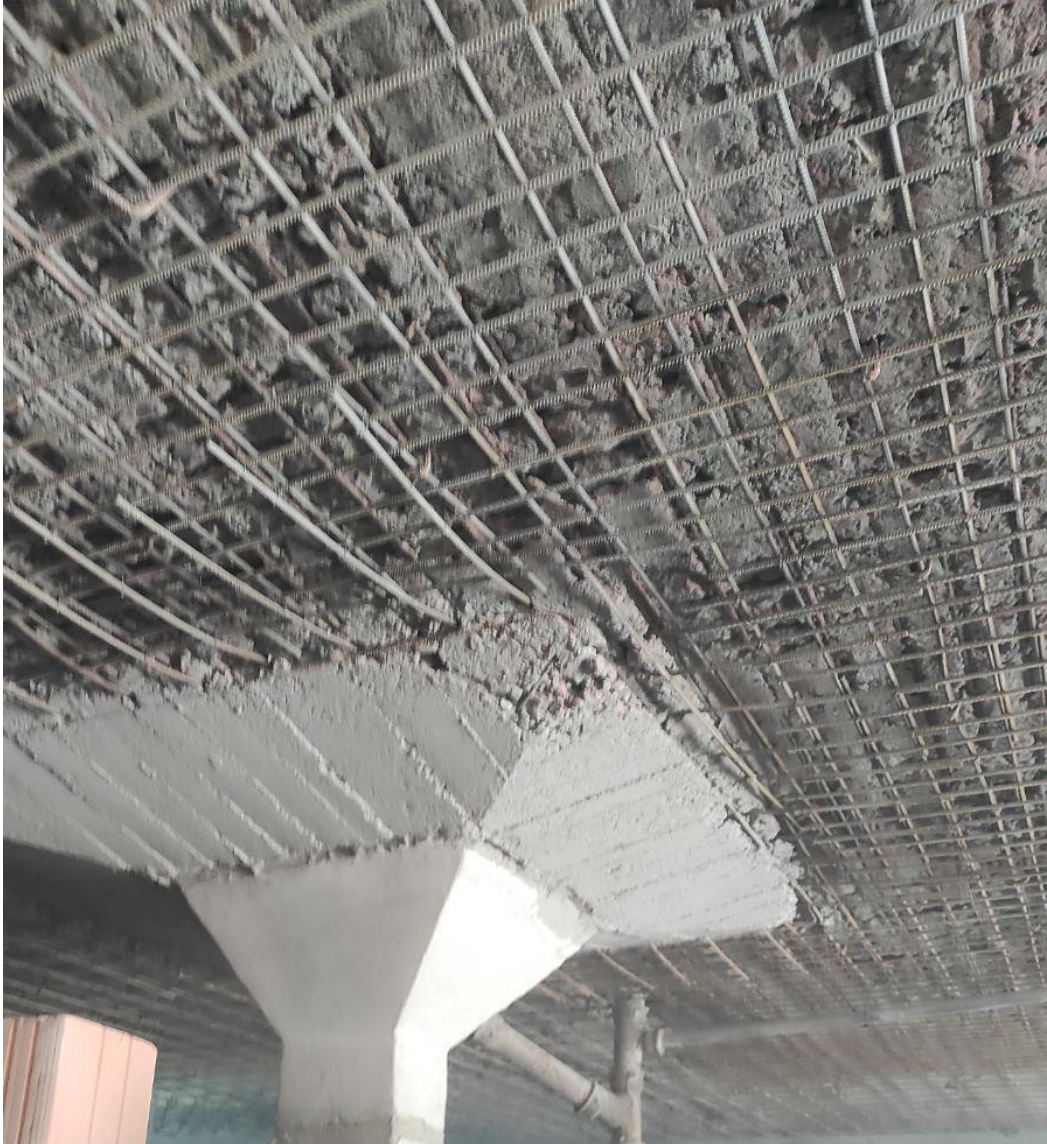
Рис. 2. Армування плити перекриття
