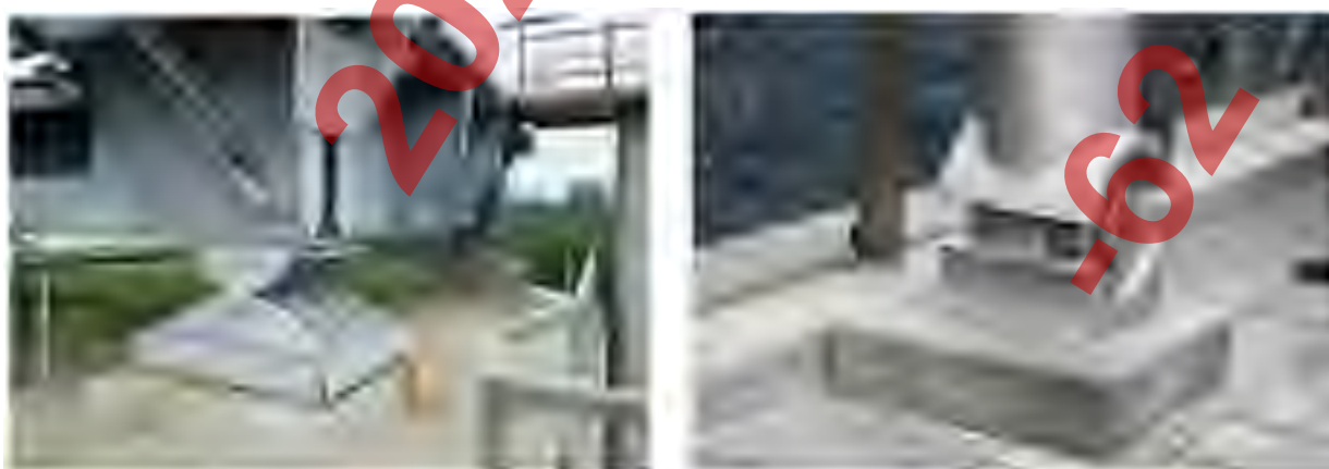
Рисунок 1.2 – Шарнірні опори.
