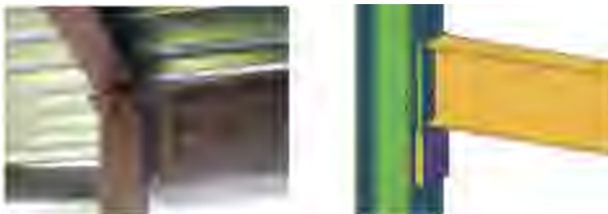
Рисунок 1.3 – Шарнірні вузли з податливими елементами.
