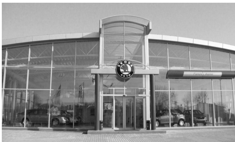
Рисунок 1.4 – Зовнішній вигляд будівлі СТО
