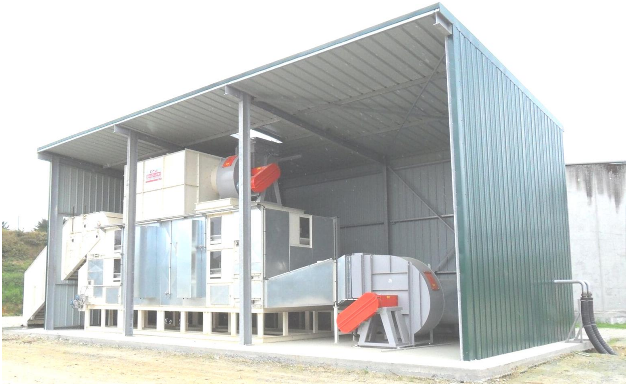
Рис. 1.2 – Загальний вигляд вуличної сушарки Scolari [7]
