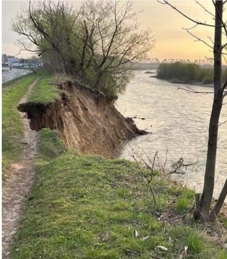
Рис. 2. Обвал земляної дамби на трасі Київ – Чоп внаслідок весняної повені річки Стрий у 2024 році [4]
