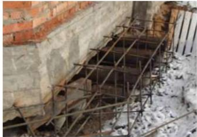
Рис 6.5. Підсилення фундаментів методом збільшення ширини підшви фундаменту.
