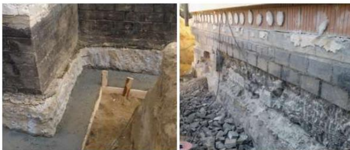
Рис. 6.1. Початкові етапи зміцнення стрічкових фундаментів: ліворуч нова підшва з бетону С12/15, праворуч металеві елементи фундаментну з неякісного бетону
