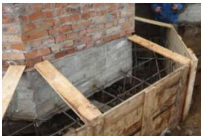
Рис 6.4. Підсилення фундаментів монолітними бетонними поширеннями підшви.
