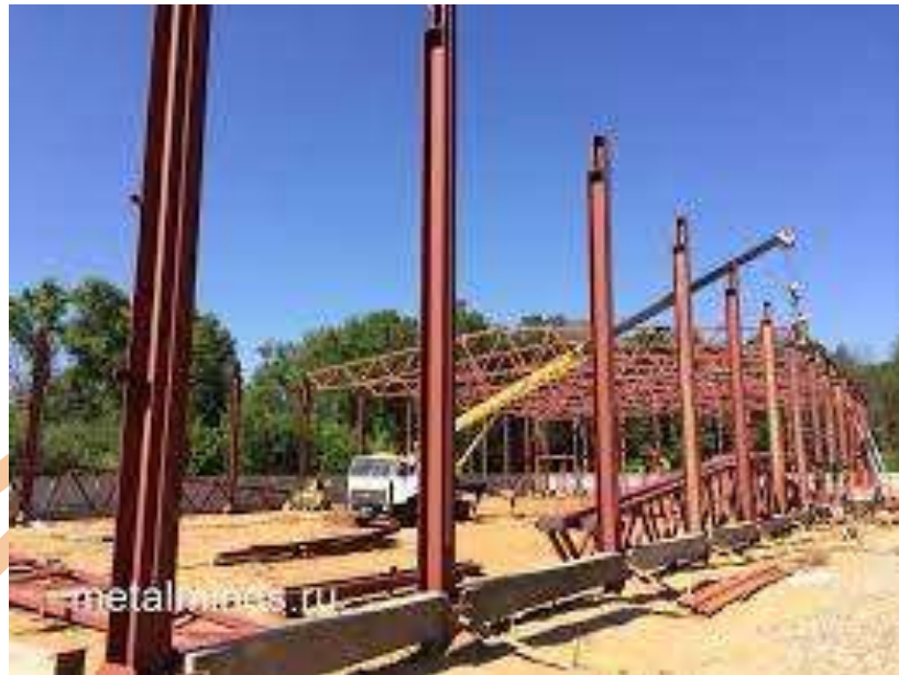
Рис.3.1. Встановлення колон
