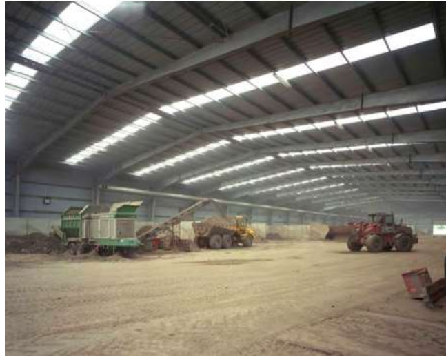
Рис. 6.2 Каркас портала двохсхилого даху.
