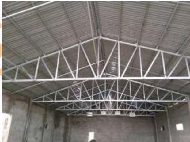
Рис. 6.3. Ферма з жорстким каркасом
