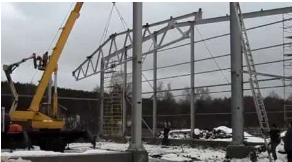
Рис 3.2. Монтаж ферм
