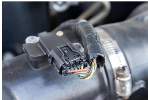
Рисунок 3.2 – Неякісне з'єднання електропроводників.
